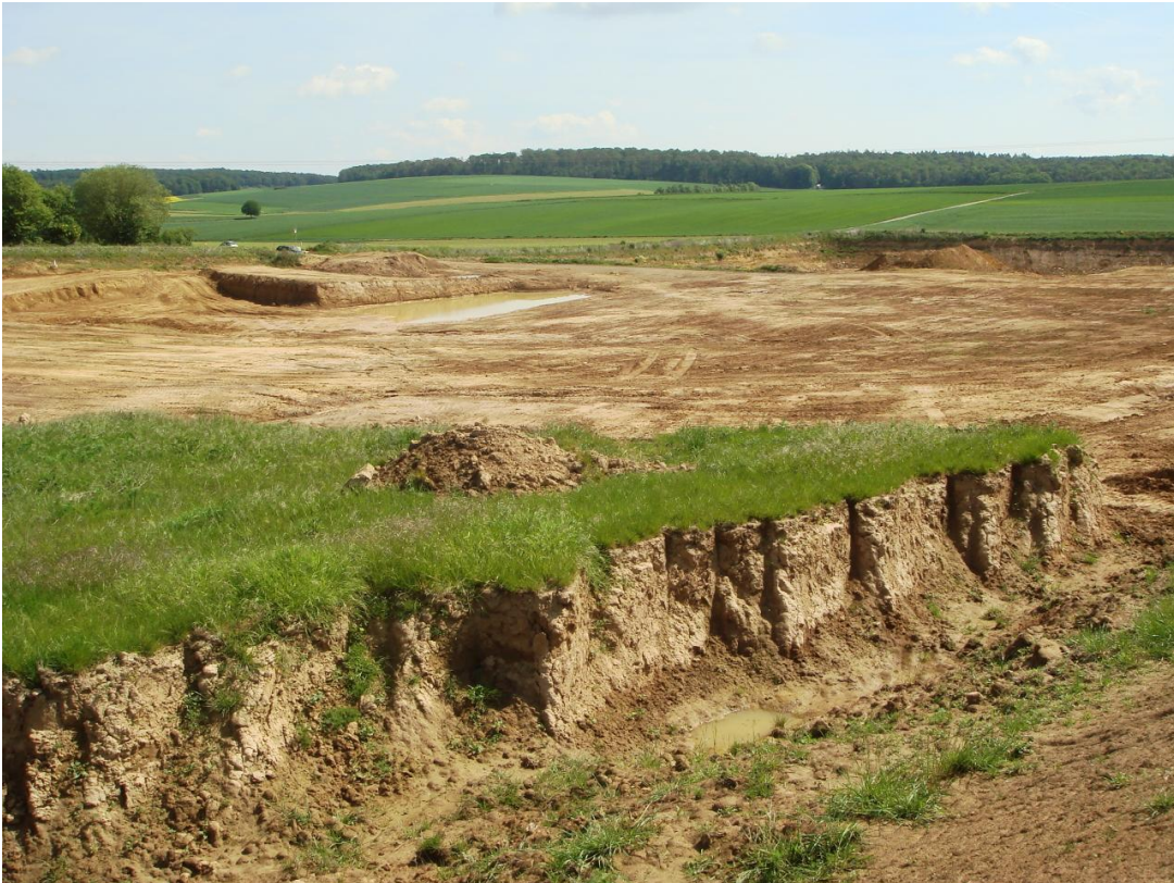
Geplantes Deponiegelände (Abbaufäche) bei Ziegelei ca. 2 km sö Helmstadt, Blickrichtung Nordost, 26.05.2019
