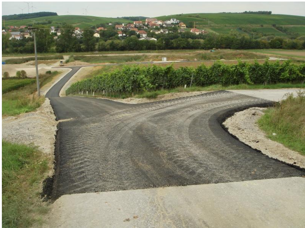
Foto 12 Feldflur im Nordosten der Abbaustelle, Blickrichtung West, 05.09.2020: Im Vordergrund neu angelegte westliche Zufahrt, im Hintergrund Obereisenheim
