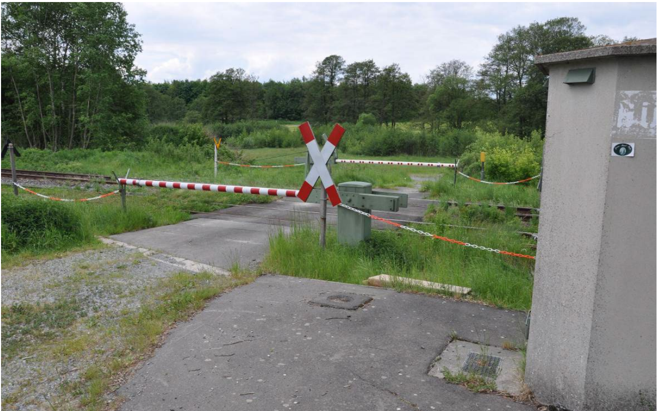
BÜ Bahn-km 117,67; Blick Richtung Westen
