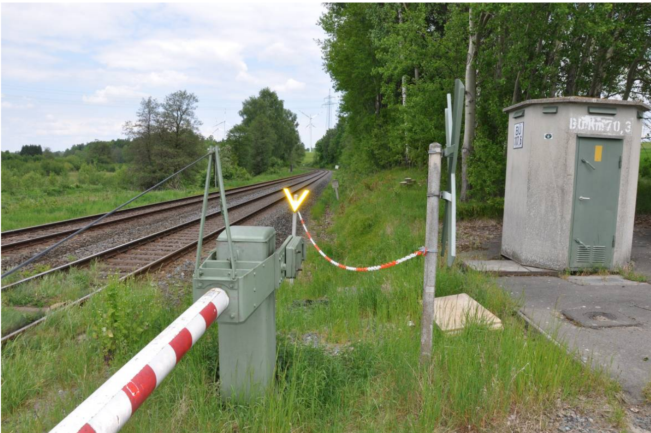
BÜ Bahn-km 117,67; Blick Richtung Norden
