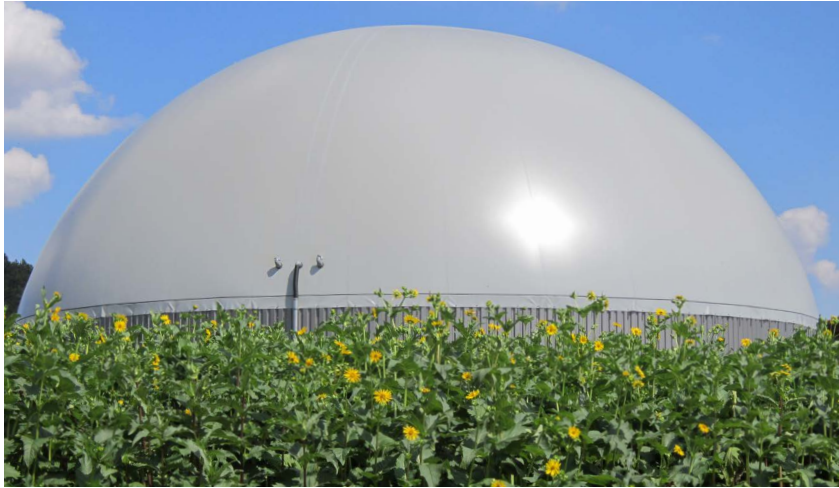
Silphie im Bestand mit Biogasanlage im Hintergrund
