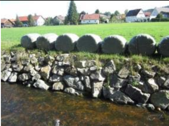
Abb. 1: Siloballen direkt am Gewässer, Verklausungsgefahr bei Hochwasser. Foto: L. Guffler, LRA Weilheim
