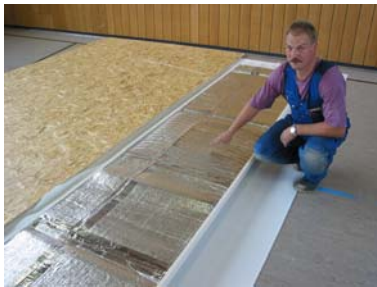
Deckenstrahlplatten rückseitig
