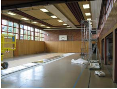
Während der Montage
