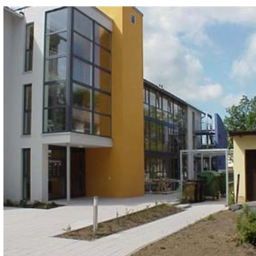
Vorwerkstraße 44 nach der Sanierung
