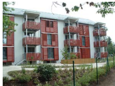
Vorwerkstraße 44 nach der Sanierung
