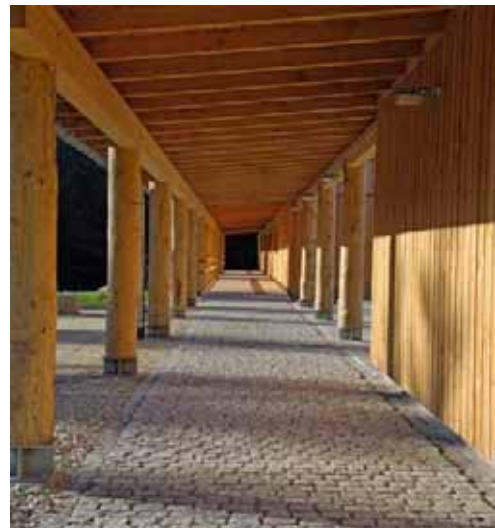
Die Holzbauweise ist auch im Laubengang sehr deutlich sichtbar.
