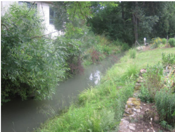
Abb. 10: Staubereich oberhalb Brücke in Steinbach
